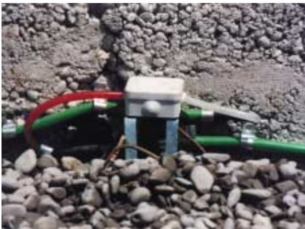
• Abdichtung mit PREDIMAX® Boden/Wandfugen
