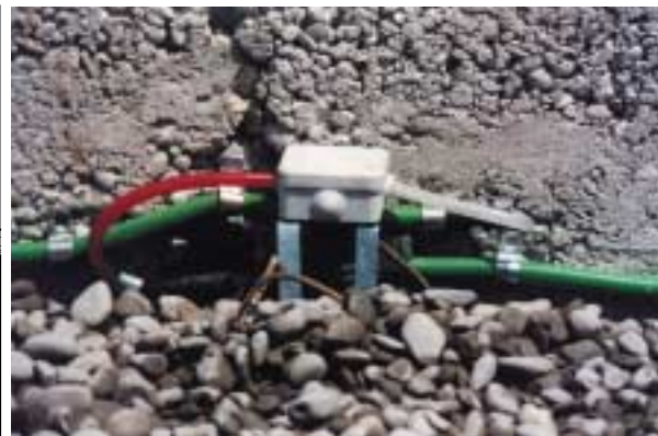
Abdichtung mit Predimax/Boden/Wandfugen.
