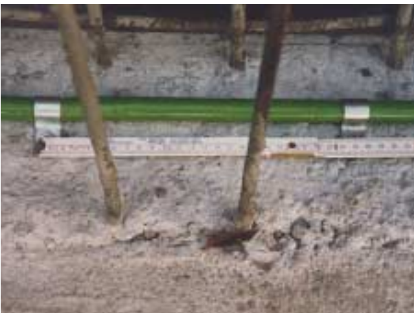
• Anschließen der Schellen im Abstand von ca. 25 - 30 cm je nach Beschaffenheit der Betonfuge.
