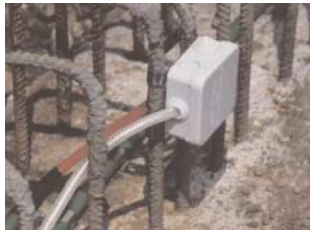
• Verlegen der Lüftungsschläuche in eine Verwarbox
