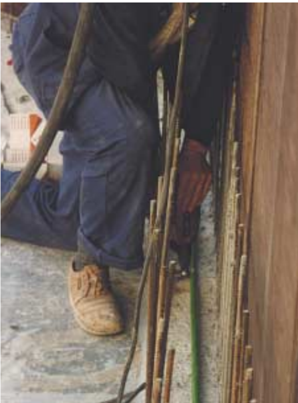
• Auslegen des Schlauches in die Armierung
