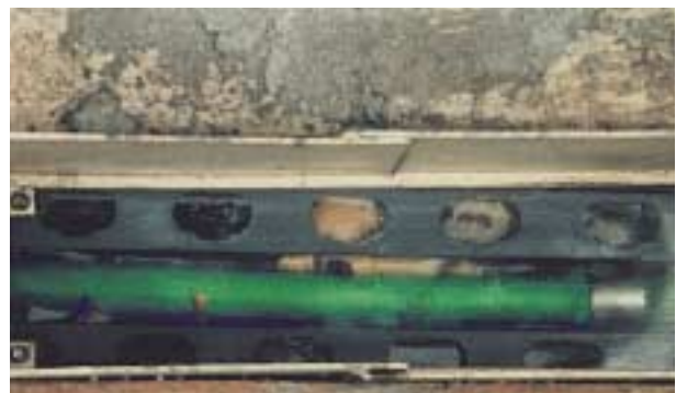
• Das Schauglas in eine Fuge zeigt wie Schaum aus dem Schlauch austritt und sich verteilt
