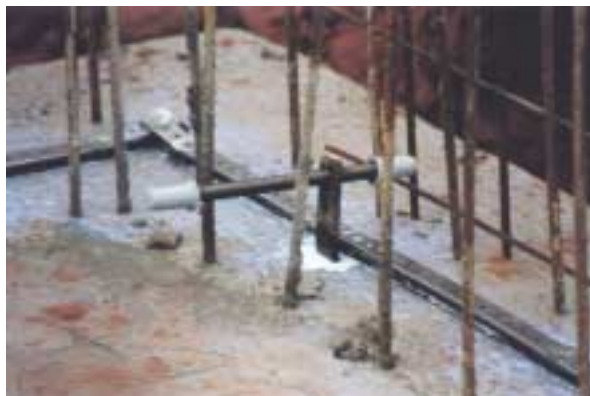
Abdichtung mit Quellmax/Boden/Wandfuge. Quellbänder stellen die einfachste Form der Fugenabdichtung dar. Foto: Rolf Pflieger Bausysteme
