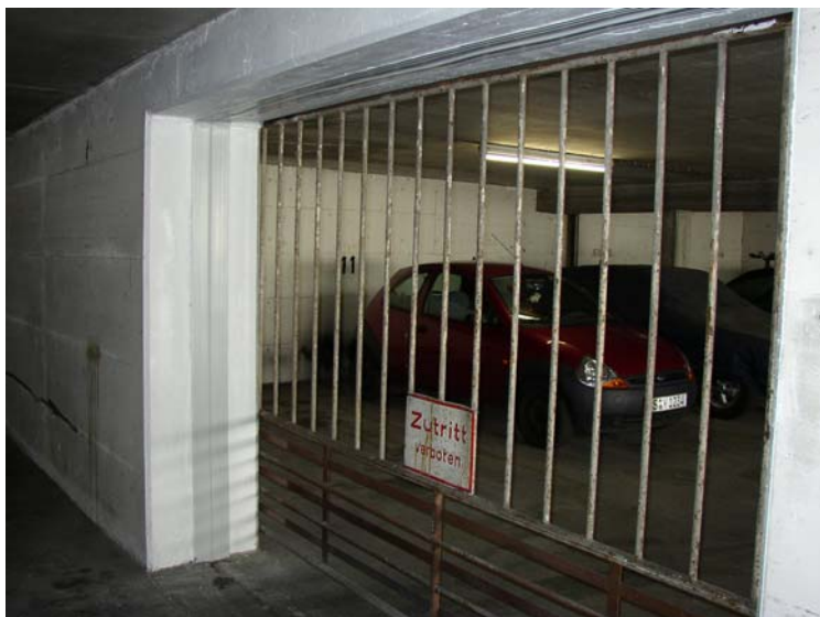
Dehnfuge Sanierung innenseitig
