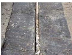
Dehnfuge Sanierung wasserseitig
