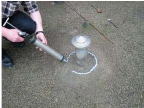
Durchdringung - Sanierung
