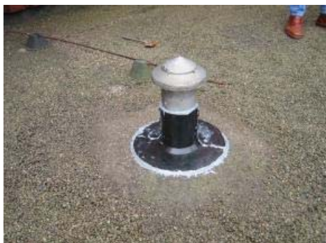
Durchdringung - Sanierung
