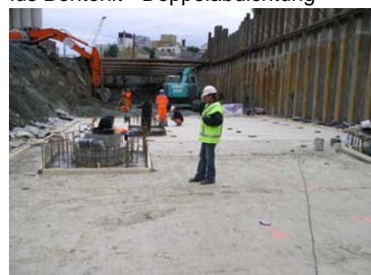
Die Abdichtung erfolgt mit CEMtobent® CS-Plus Bentonit - Doppelabdichtung
