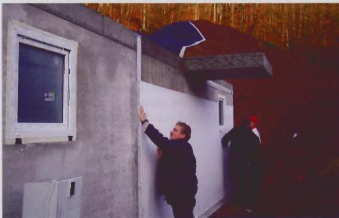
Die Flächenabdichtung CEMproof® EasySeal Quellvlies quillt bei Wasserzutritt, dichtet und gelt an der Oberfläche (Foto: BPA/CEMproof)
